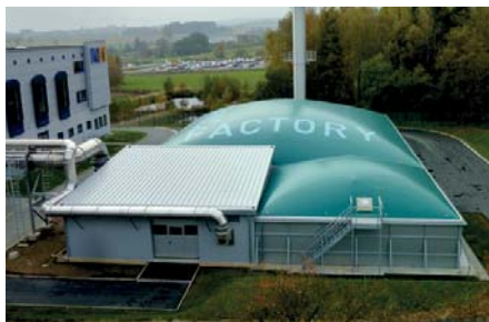
Im Becken der Anlage dienen 2050 m 3 Holzhackschnitzel als Biofilter. Quelle: KH
