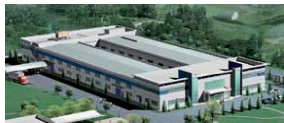
Neues Gebäude 2007 · New Building 2007
